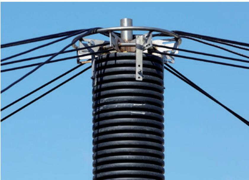
► Structure de soutien de la bâche par des supports de tension Cablor® en résine avec couronne inox au faitage
