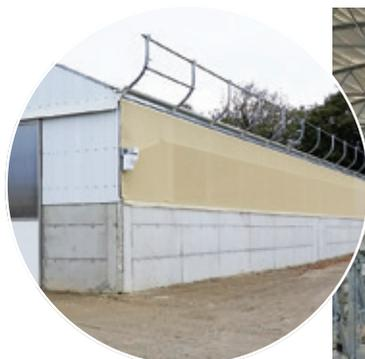
Des filets brise-vent associés à des bâches déroulantes permettent une aération optimale.
