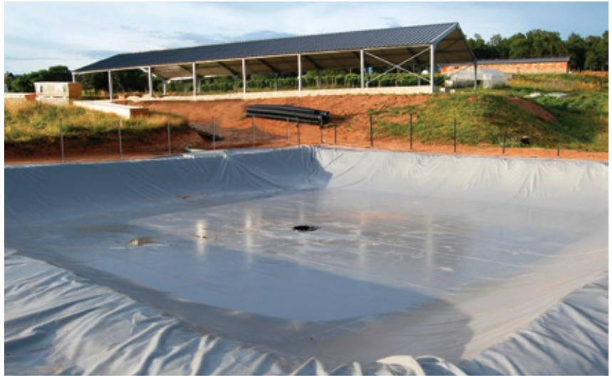
La couverture repose au fond de la lagune lorsqu'il n'y a pas d'effluent.
