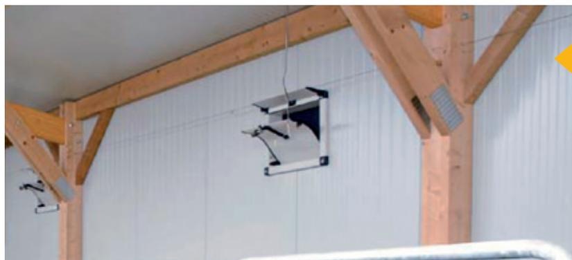
L'air entre par les quatre volets automatisés et sort par les deux cheminées sur le toit (troisième cheminée au-dessus de la laiterie). Le portail, étanche, facilite le nettoyage et l'évacuation des animaux.
