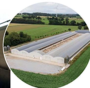
Le bâtiment se compose de 2 tunnels avec deux nefs et une cour d'hiver protégée par un filet anti-oiseaux.
