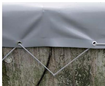
► Cèllets inox tous les 25 cm fixés par un sandow de diamètre 10 mm sur crochets inox
