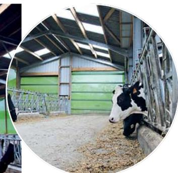
Les portes à enroulement se contrôlent grâce à la télécommande et permettent à l'éleveur de les ouvrir depuis son tracteur.
